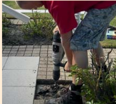
Schritt 1: Montageplatz vorbohren
