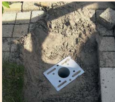
Schritt 4: Schraubfundament eingedreht
