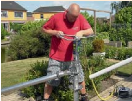
Schritt 3: Schraubfundament eindrehen
