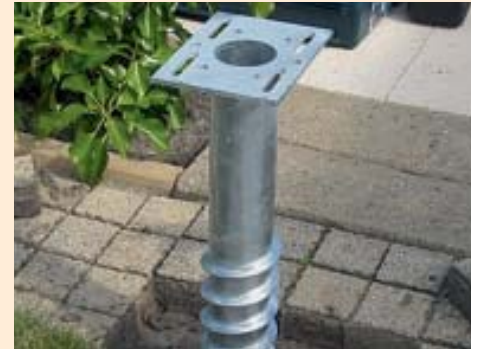
Schritt 2: Schraubfundament positionieren
